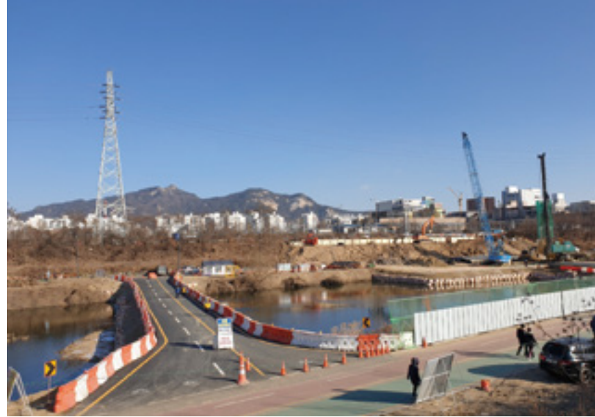
▲ 공사 중인 중랑천
