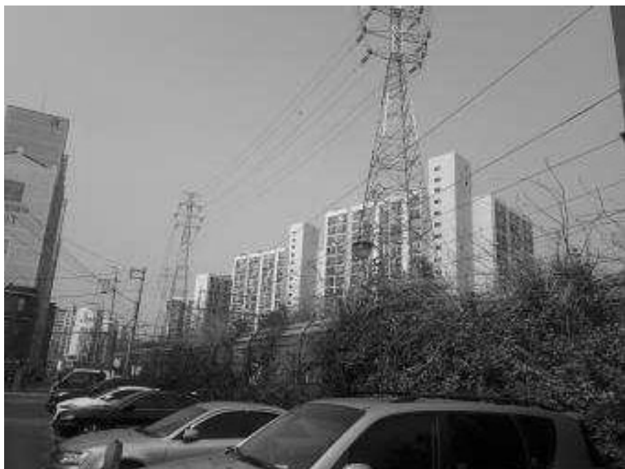
월계동 사슴 1아파트 단지내 송전탑 및 송전선로
