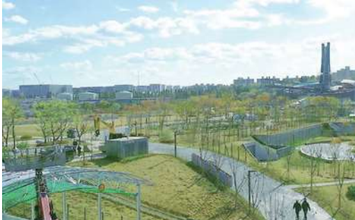
휴게형 테마공원 (공사 중)
