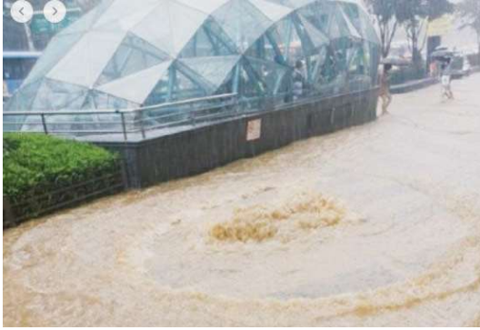
맨홀 추락방지시설 설치 전 - 맨홀 역류 사진
