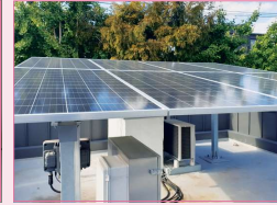
태양광 모듈 설치
