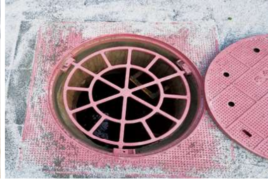
맨홀 추락방지시설 설치 사진
