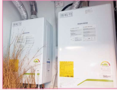
친환경보일러 교체 설치
