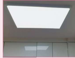
LED 조명 설치
