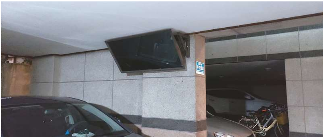
필로티주차장 천장 모서리거울
