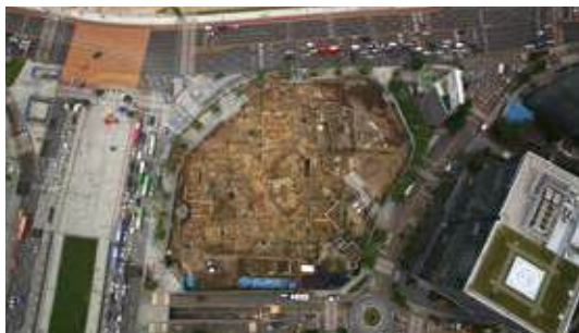
발굴조사 현장 전경
