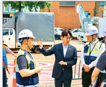
노원지역 송전선로 지중화 공사 현장점검
