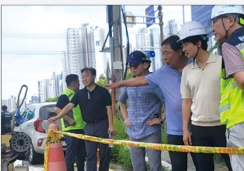
월계2동 우이천변 도로 지반침하발생 지점 현장 점검
